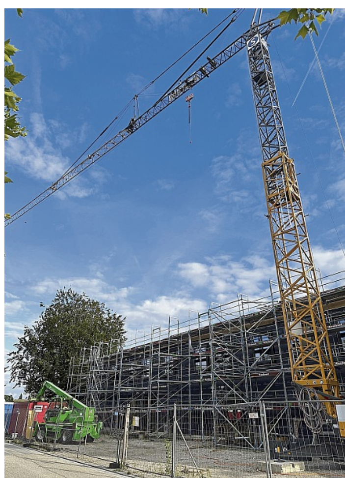
Bereit zum Abriss: Im Moment sind Kran und Bagger an der Kinderhaus-Ruine noch in Warteposition. KATHRIN KAPFER
